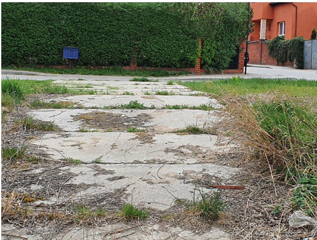
Droga dojazdowa do istniejących separatorów
