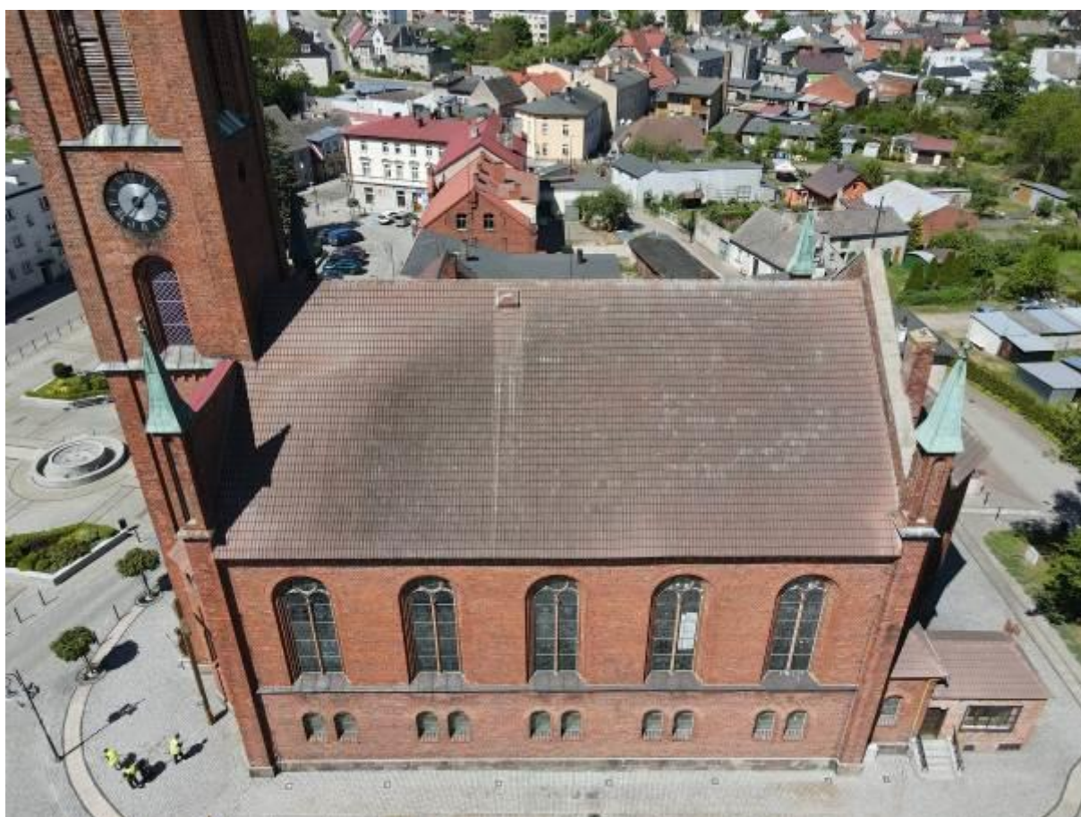
Remont zabytkowego Kościoła św. Stefana w Barwicach
