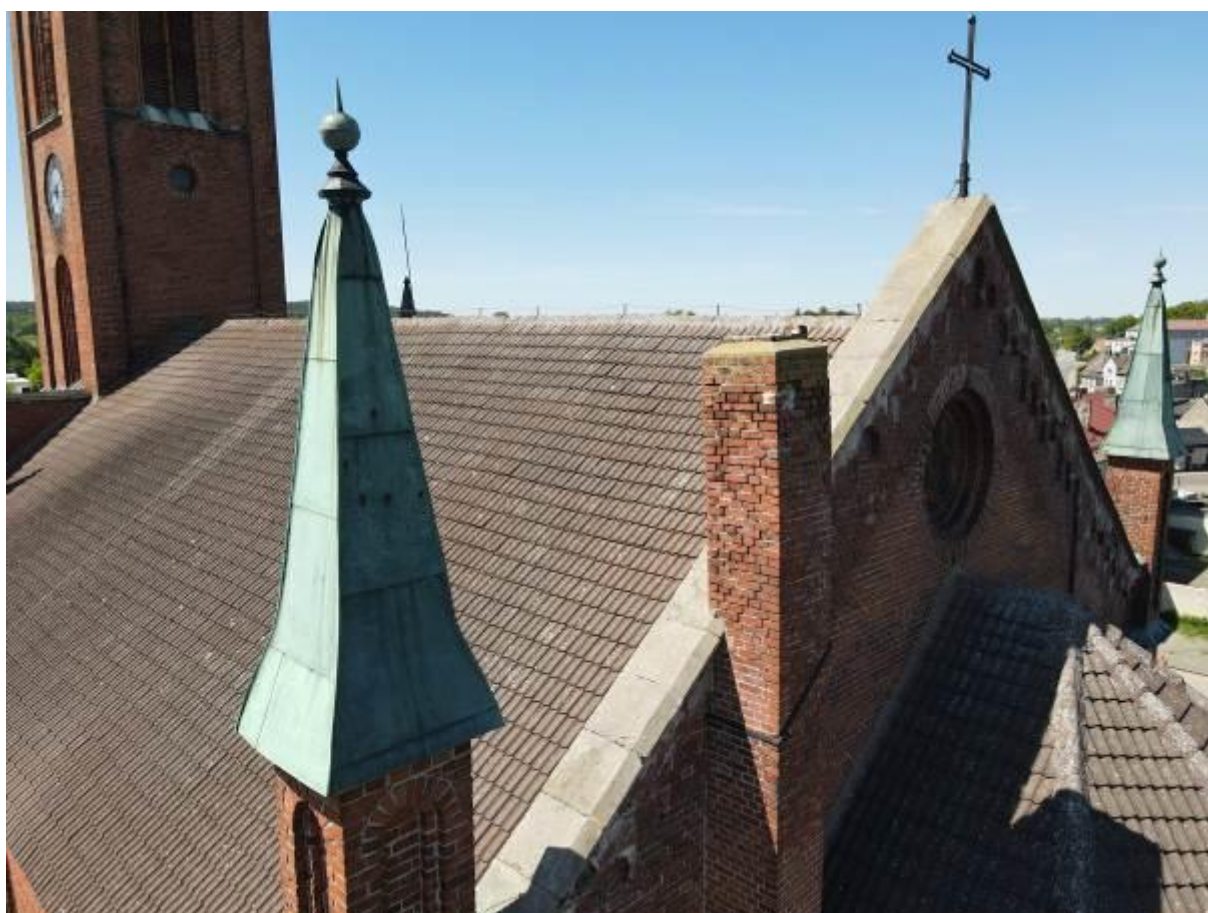
Remont zabytkowego Kościoła św. Stefana w Barwicach
