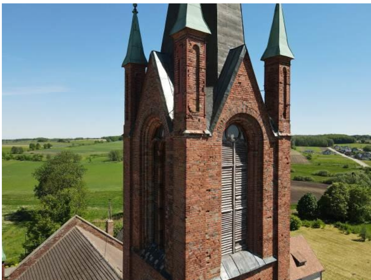
Remont zabytkowego Kościoła św. Stefana w Barwicach
