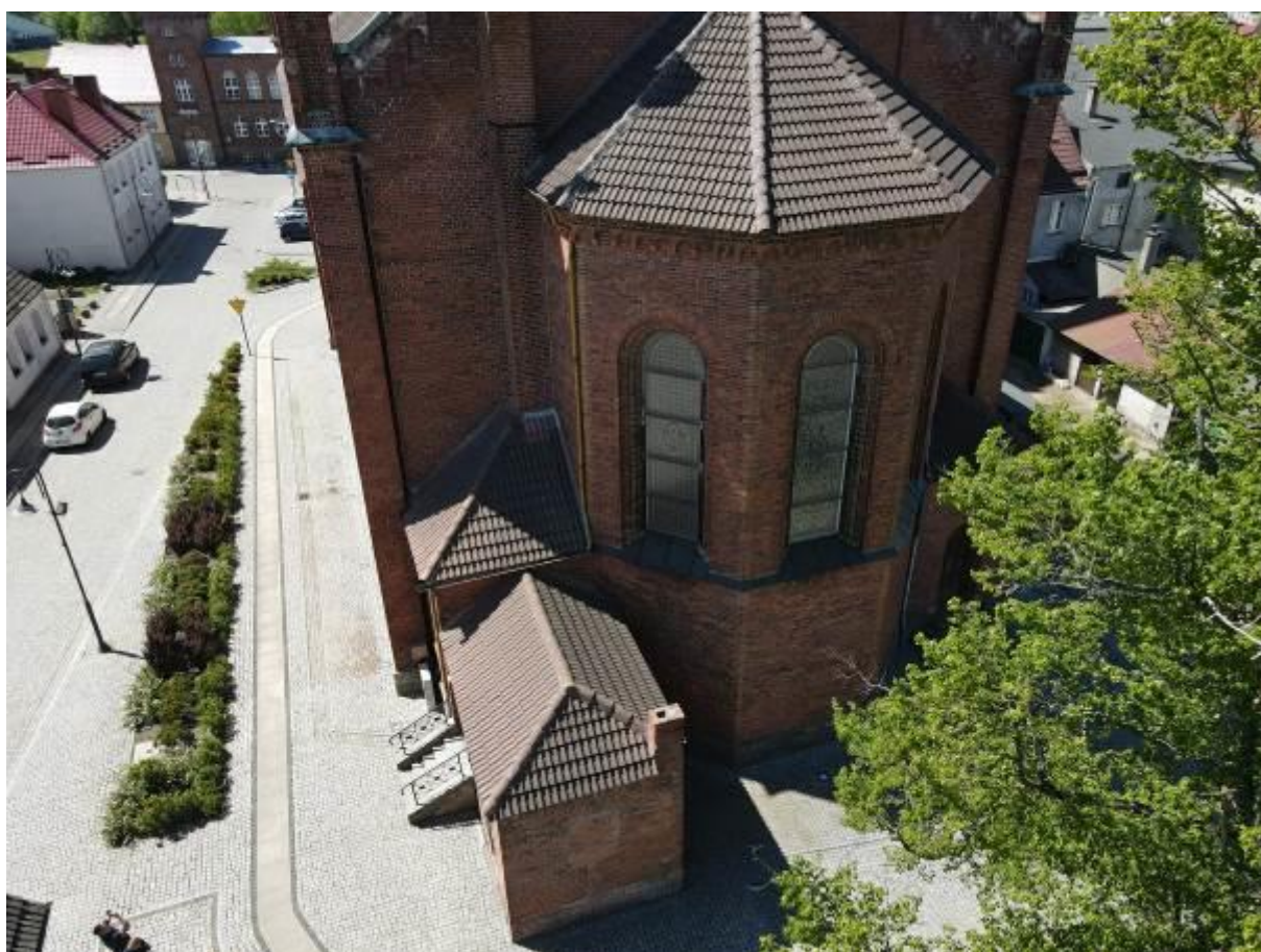
Remont zabytkowego Kościoła św. Stefana w Barwicach
