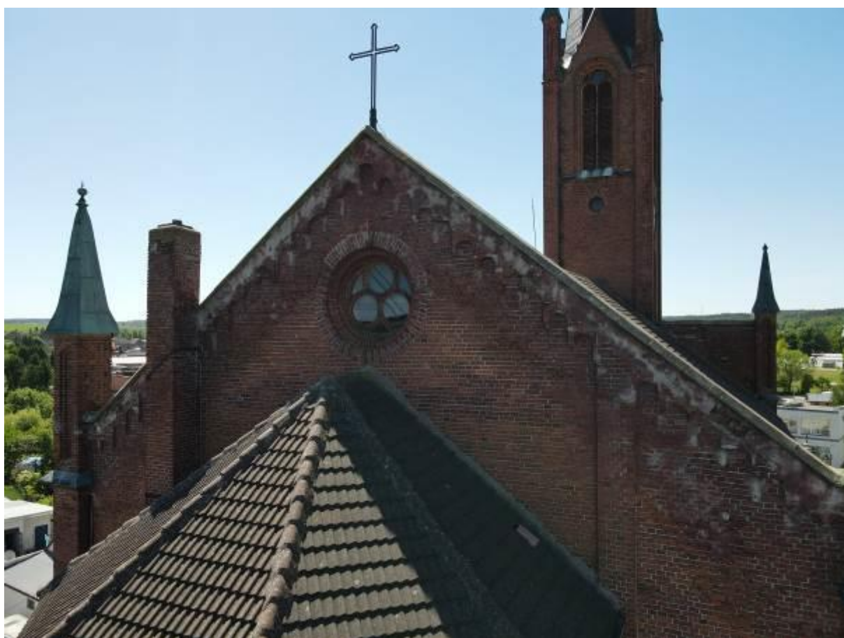
Remont zabytkowego Kościoła św. Stefana w Barwicach
