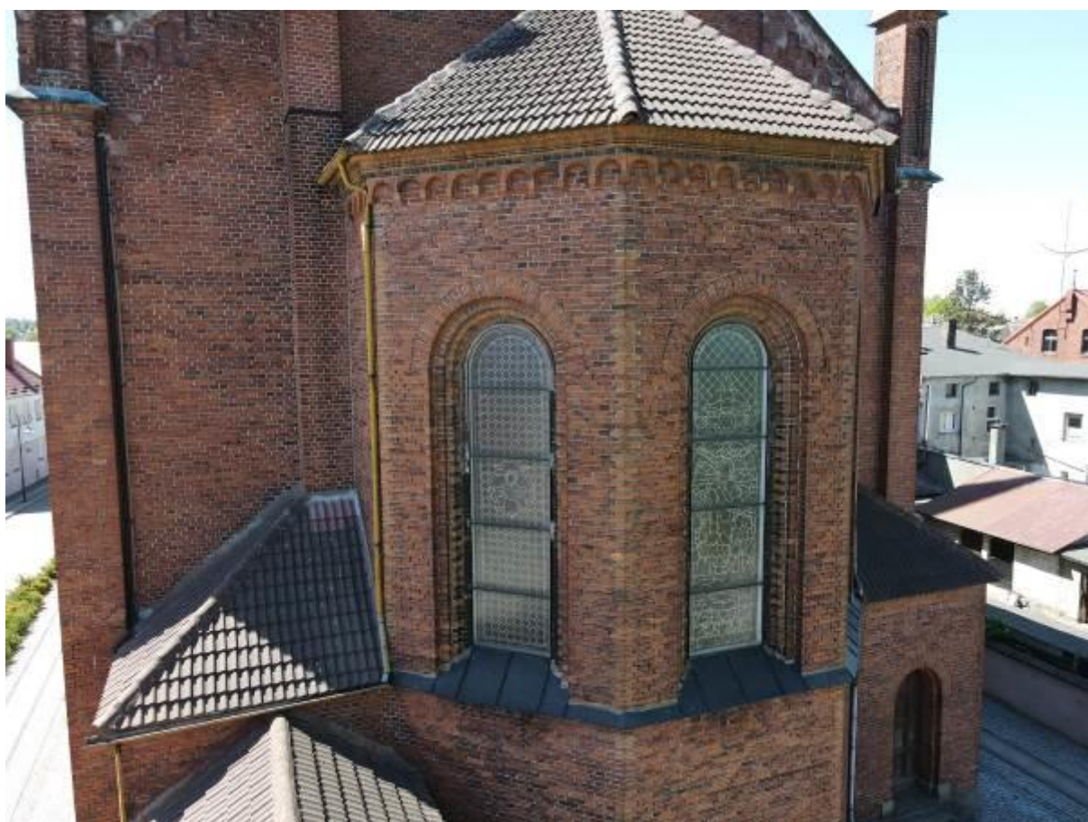
Remont zabytkowego Kościoła św. Stefana w Barwicach
