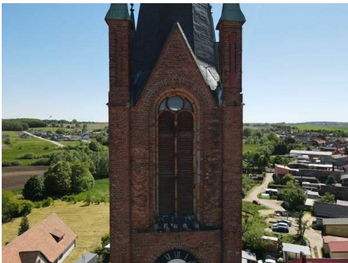
Remont zabytkowego Kościoła św. Stefana w Barwicach
