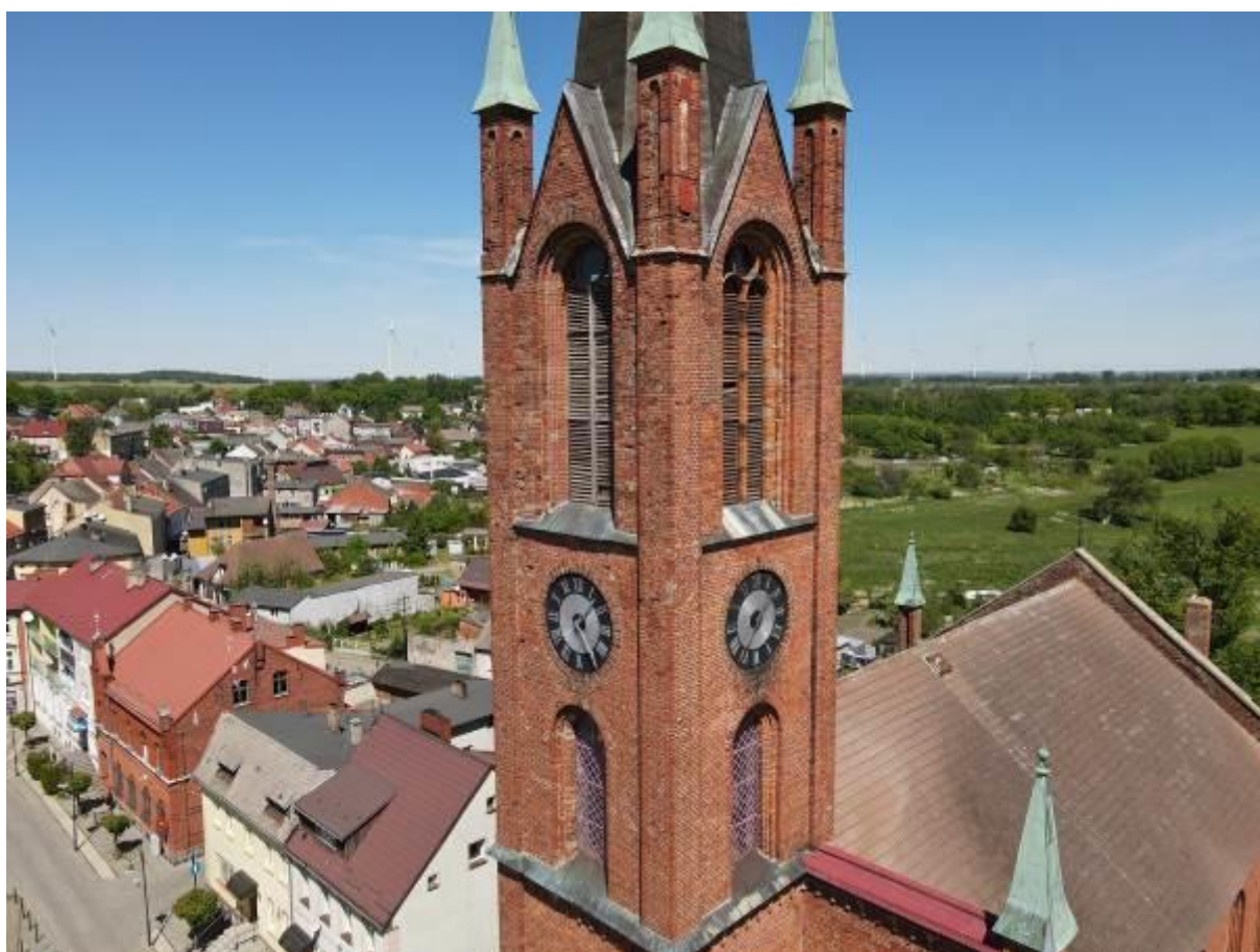
Remont zabytkowego Kościoła św. Stefana w Barwicach
