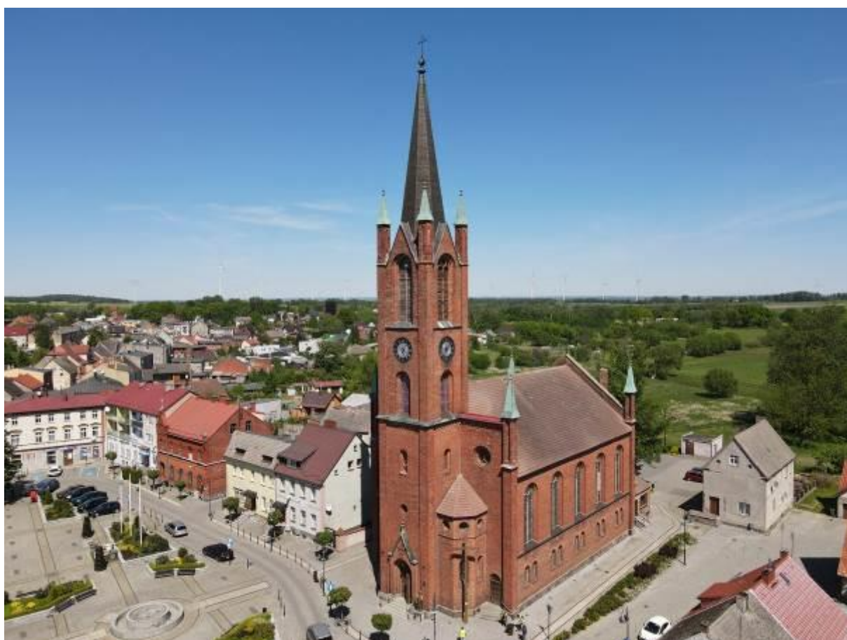
Remont zabytkowego Kościoła św. Stefana w Barwicach
