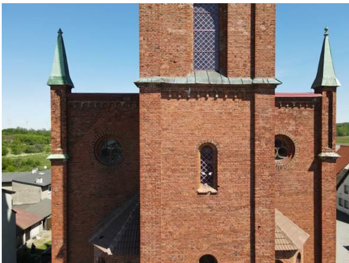
Remont zabytkowego Kościoła św. Stefana w Barwicach
