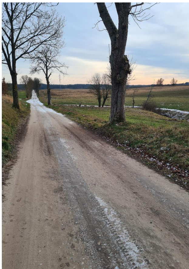
Fot. 1 Istniejąca droga gminna.
