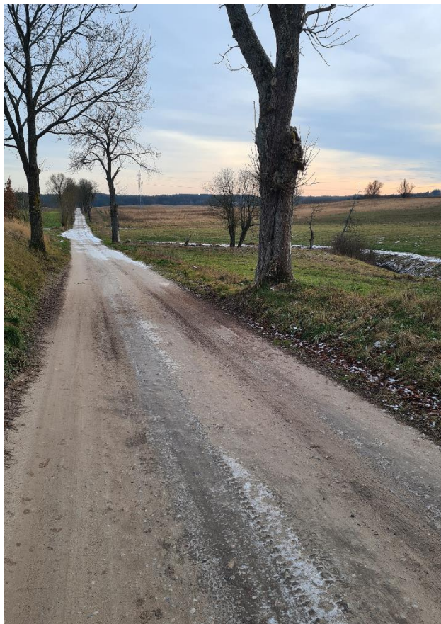
Fot. 1 Istniejąca droga gminna.
