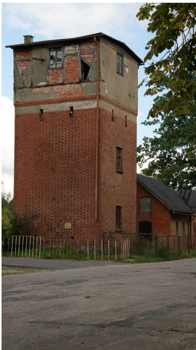
Barwice -wieża ciśień
